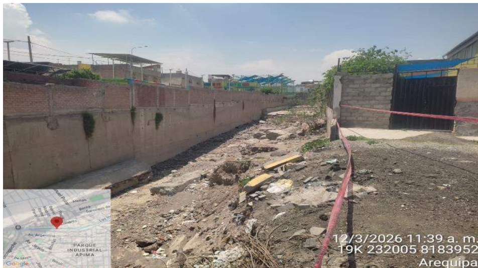
IMAGEN 01: SE OBSERVA LA MARGEN IZQUERDA SIN MURO DE CONTENCIÓN Y EROSIONADA
