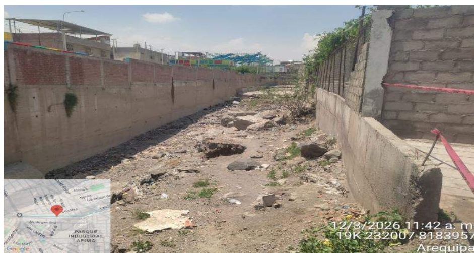
IMAGEN 02: SE OBSERVA LA MARGEN IZQUIERDA QUE REQUIERE DE UN MURO EVITAR LA POSIBLE AFECTACION A VIVIENDAS, FAMILIAS AGUAS ABAJO
